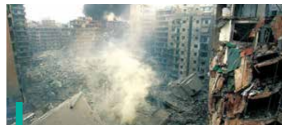
Des bâtiments en ruine.
