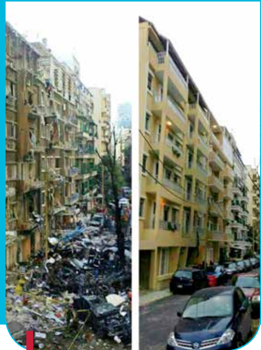
Le quartier d'Achrafieh avant et après la réhabilitation par la cellule génie civile suite à l'attentat d'octobre 2012.
