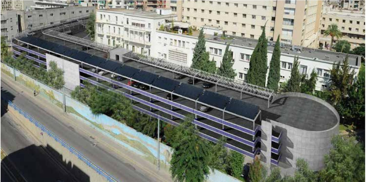
L'Hôtel-Dieu de France a inauguré un nouveau bâtiment de parking pouvant accueillir 650 voitures. Le toit du bâtiment est équipé d'une série de panneaux solaires photovoltaïques reliés à des compteurs intelligents qui permettent de reverser l'excédent de production d'électricité vers le réseau d'EDL.
